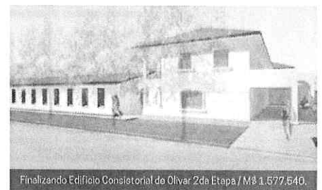
Finalizando Edificio Consistorial de Olivar 2da Etapa / M$ 1.577.540.
