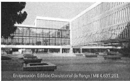
En ejecución Edificio Consistorial de Rengo / M$ 4.637.261.
