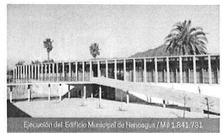
Ejecución del Edificio Municipal de Nancagua / M$ 1.841.731.
